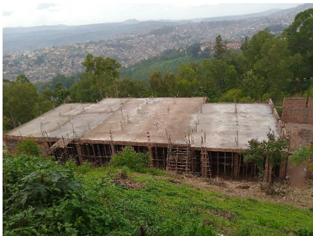
Figure 11 : Nouveau chantier pour les laboratoires de Pharmacie et auditoire, 2020. Partie dallée
