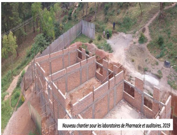
Figure 10 : Nouveau chantier pour les laboratoires de Pharmacie et auditoire, 2019.
